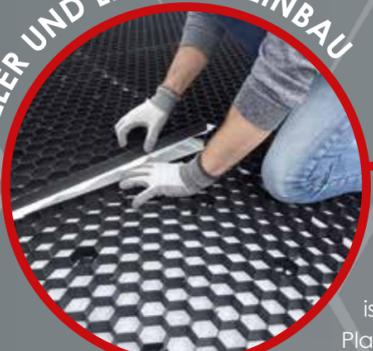
Die nida gravel Wabenplatten sind einfach und ohne Verankerung zu installieren. Für das Zurechtschneiden ist keine spezielle Ausrüstung erforderlich. Die Platten passen sich außerdem an alle Formen an.
